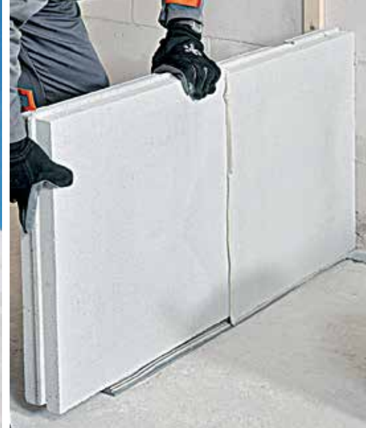
bauroc LUX on mittatarkka ympäripontattu väliseinälaatta
